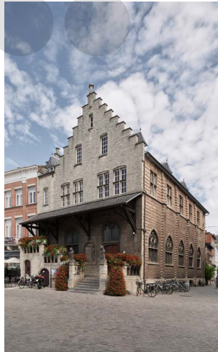
Restauratie Vleeshuis | Lier
