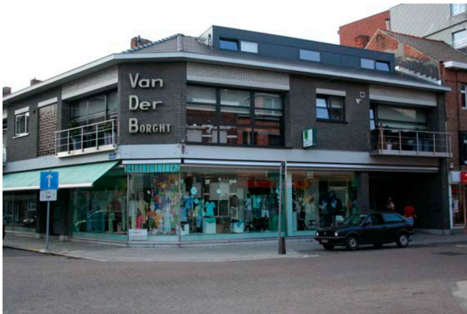
Renovatie appartement boven handelsruimte.
